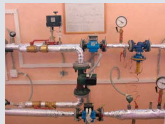
Рис. 3. Фото теплового узла после реконструкции.
